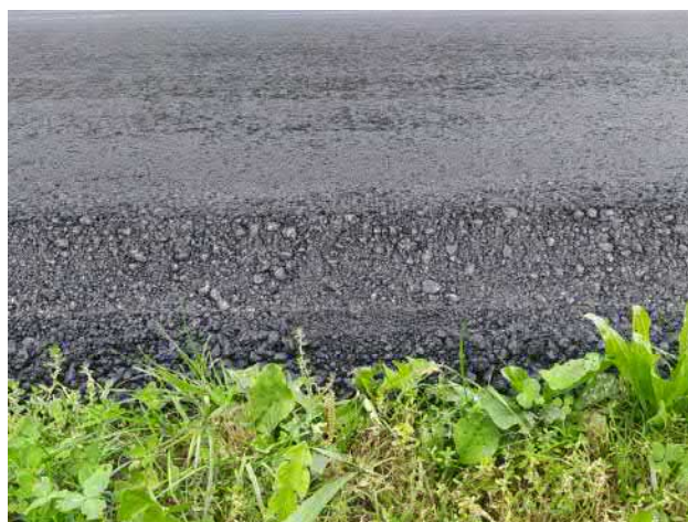
Mit Pflanzenkohle angereicherter Asphalt, Foto: Thomas Zumbrunn
