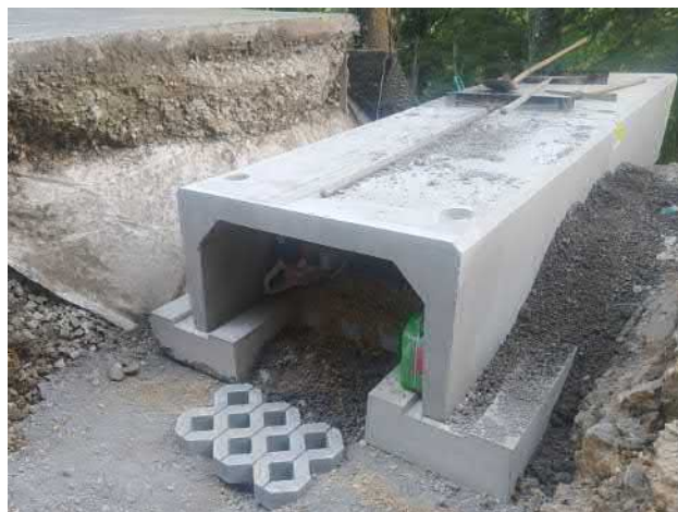
Kleintierdurchlass im Bau, Foto: Thomas Zumbrunn
